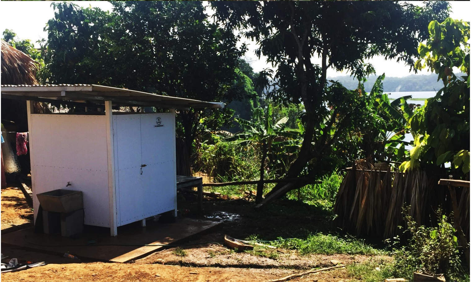
Fuente: MINSA, Izquierda: Caseta de Saneamiento. Derecha: Enramada usada como baño antes del proyecto. Aguas Claras, Chepo, 2016.
